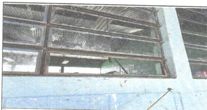
Foto 5: Instalacion de vidrios transparentes.
