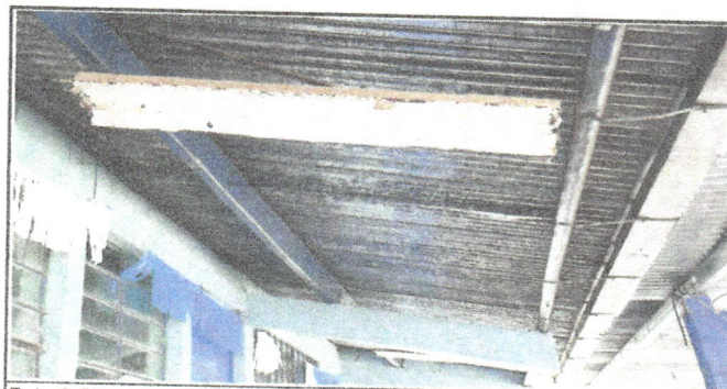
Foto 6: Mantenimiento del sistema electrico.
