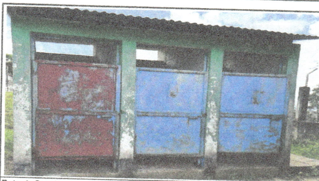
Foto 4: Sustrucion de puertas de metal.
