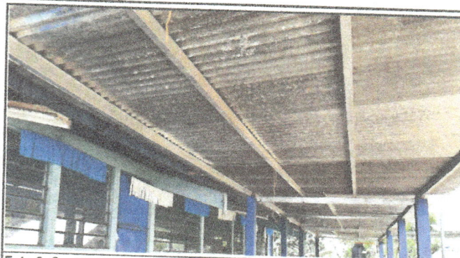
Foto 2: Sustrucion de estructura de techo del del corredor.
