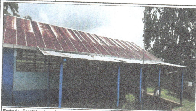
Foto 1: Sustrucion de cubierto de lamina de 29.00 mts x 12.00 mts
